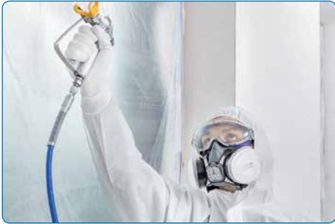
Utilisation du masque lors des travaux de peinture Airless sur paroi ou façade
